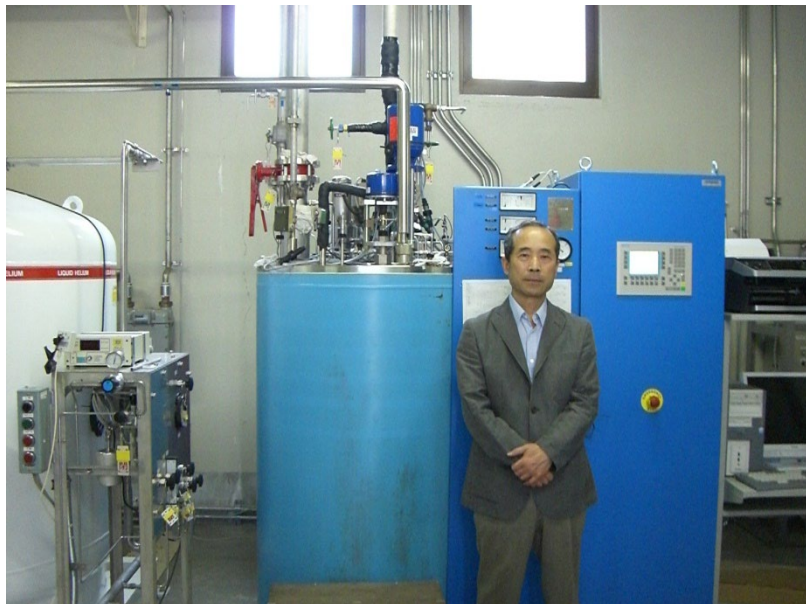
（写真 部分更新完了後試運転の時 撮影 2007 年 5 月 7 日）
